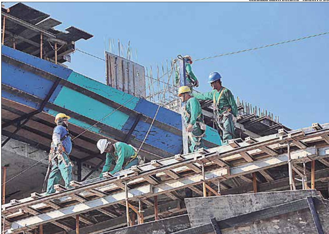
A construção em Minas foi responsável pela geração de 6.243 empregos em março
